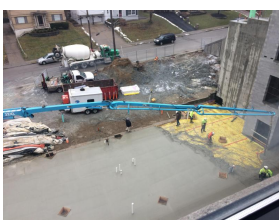
Image: Crews pour the concrete for the first floor slab.
